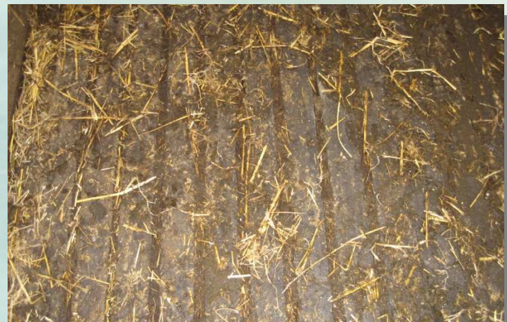
PODÉLNÉ RÝHY Vzdálenost rýh 8 – 10 cm, profil 1,5 x 1,5 cm
