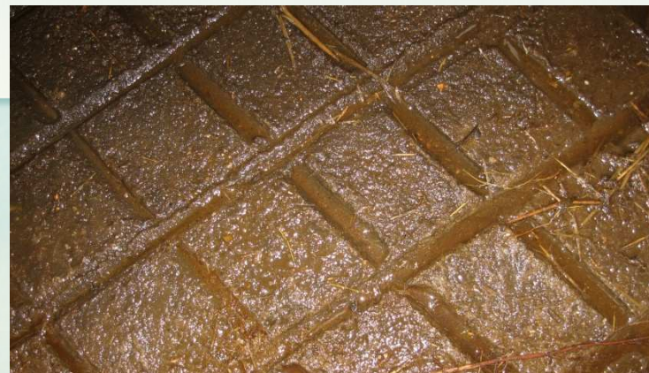
KOSOČTVEREČNÁ PROFILACE POUZE PRŮCHODY DO KRMIŠŤ!
